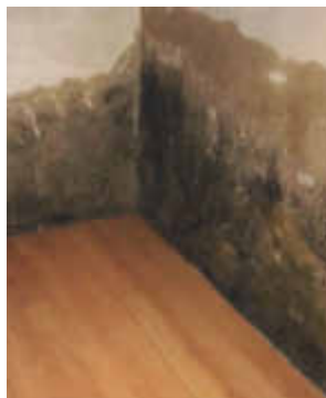
defekte Horizontalsperre
