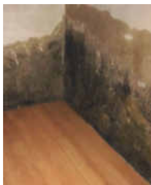
defekte Horizontalsperre
