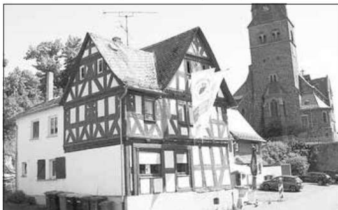
Das Heimathaus in der Stresemannstraße. Jetzt haben alle Fenster und die Haustür Paten gefunden. Foto: Thomas Klute
