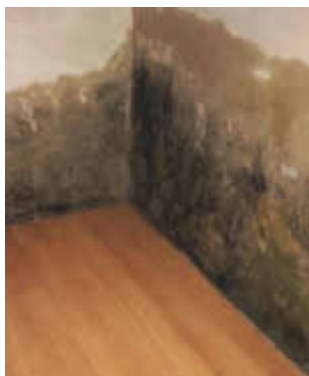
defekte Horizontalsperre
